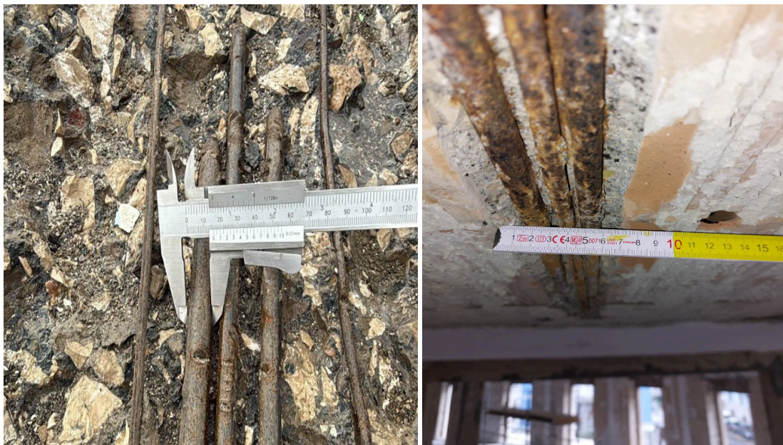
Figura 1 – Indagini e saggi sulle armature del solaio copertura
