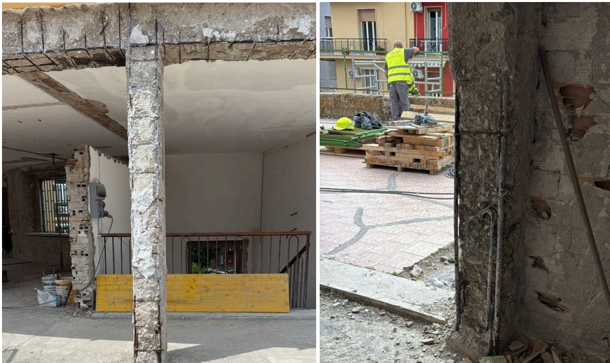
Figura 2 – Stato di degrado delle travi e pilastri del torrino di copertura.
